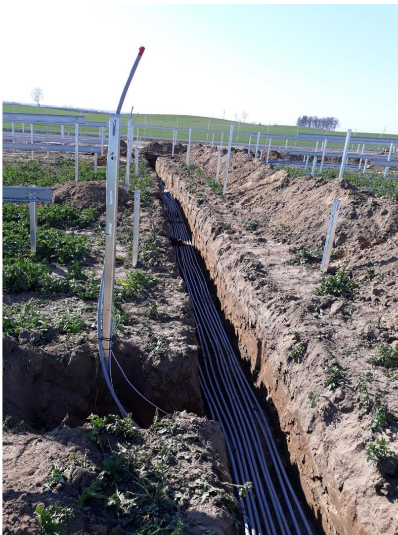
Rysunek 13 Przewody ułożone w wykopie
