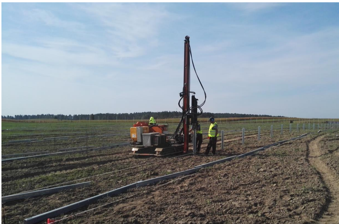
Rysunek 12 Kafar do wbijania profili nośnych
