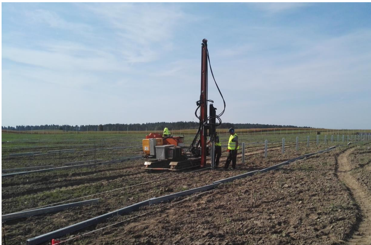
Rysunek 14 Katar do wbijania profili nośnych
