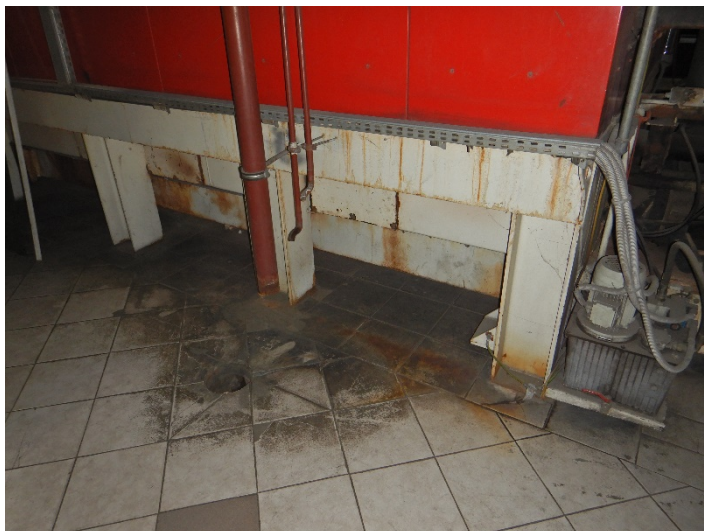
Fot. 3 Widok posadowienia kotła do modernizacji
