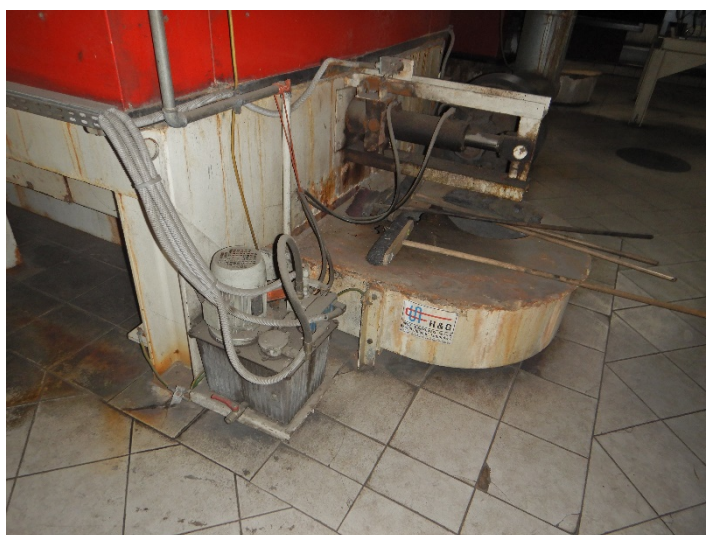
Fot. 4 Widok posadowienia kotła do modernizacji
