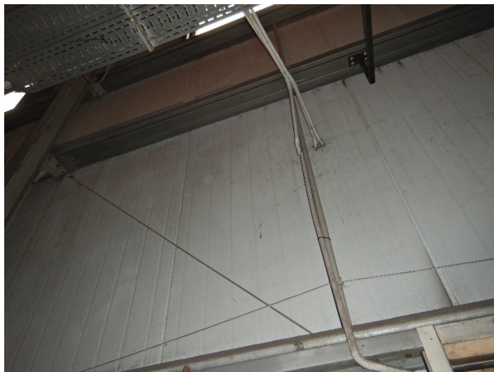
Fot. 7 Widok fragmentu ściany z płyty warstwowej do demontażu i odtworzenia w celu wystawienia oraz wstawienia nowego urządzenia
