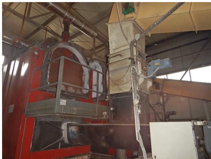
Fot. 2 Widok kotła do modernizacji
