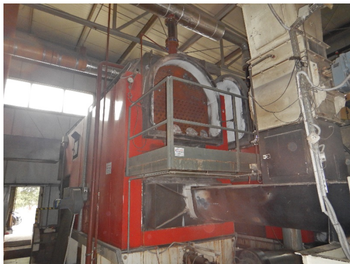
Fot. 1 Widok kotła do modernizacji
