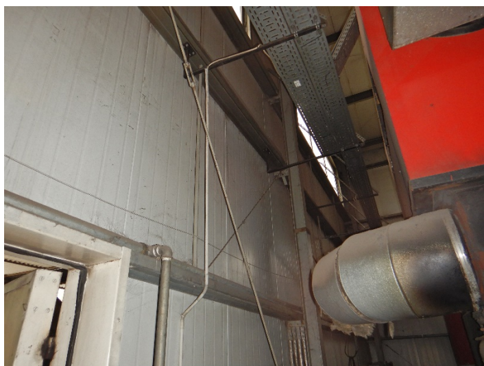
Fot. 6 Widok czopucha kotła do modernizacji
