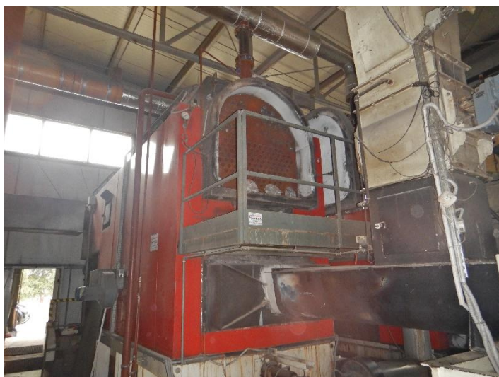
Fot. 1 Widok kotła do modernizacji
