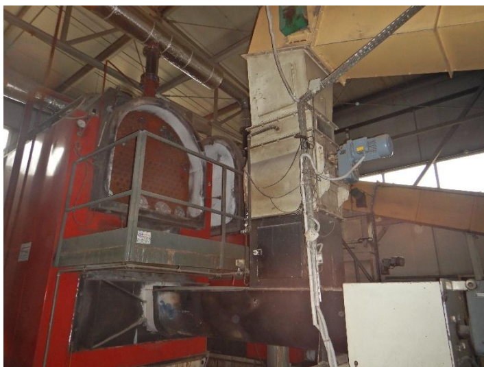
Fot. 2 Widok kotła do modernizacji
