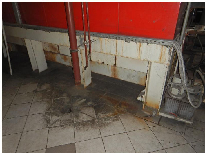
Fot. 3 Widok posadowienia kotła do modernizacji
