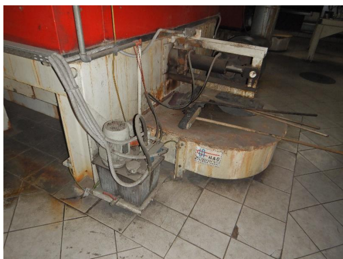
Fot. 4 Widok posadowienia kotła do modernizacji
