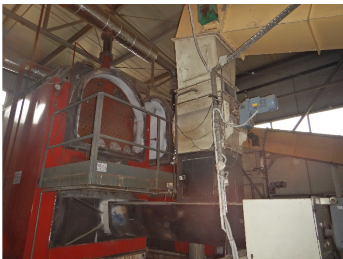
Fot. 2 Widok kotła do modernizacji
