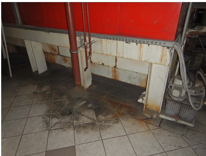
Fot. 3 Widok posadowienia kotła do modernizacji
