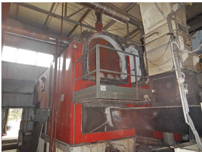
Fot. 1 Widok kotła do modernizacji
