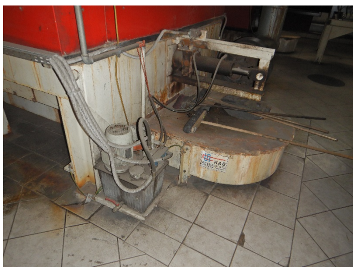
Fot. 4 Widok posadowienia kotła do modernizacji
