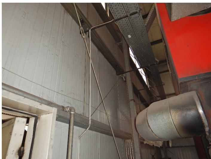
Fot. 6 Widok czopucha kotła do modernizacji
