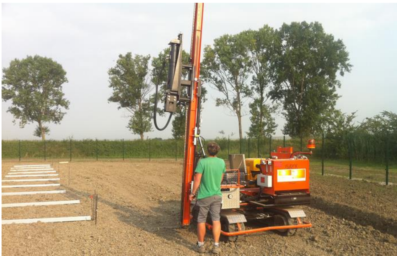
Zdjęcie nr 12. Budowa farmy fotowoltaicznej pod Parmą (Włochy), wykonanej w identycznej technologii jak planowana instalacja. Katar do wbijania profili nośnych (na drugim planie – ułożone w miejscach wbicia)
