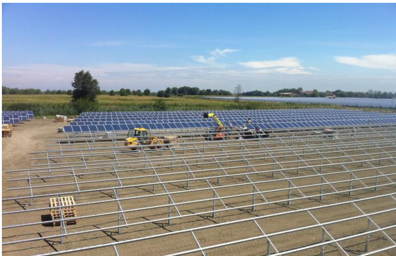
Zdjęcie nr 15. Budowa farmy fotowoltaicznej pod Parmą (Włochy), wykonanej w identycznej technologii jak planowana instalacja. Proces montażu modułów fotowoltaicznych na konstrukcji szkieletowej
