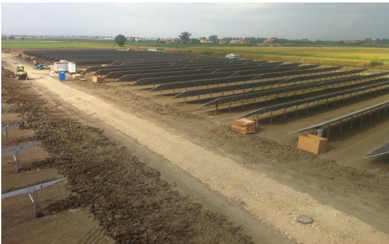
Zdjęcie nr 16. Budowa farmy fotowoltaicznej pod Parmą (Włochy), wykonanej w identycznej technologii jak planowana instalacja. Farma na jednym z ostatnich etapów budowy, po montażu modułów i zasypaniu przewodów.
